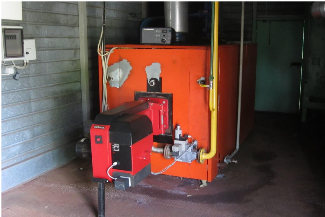
Joonis 2.3. Katel Baltur B-AR PREX 1000/1100 põletiga Oilon
