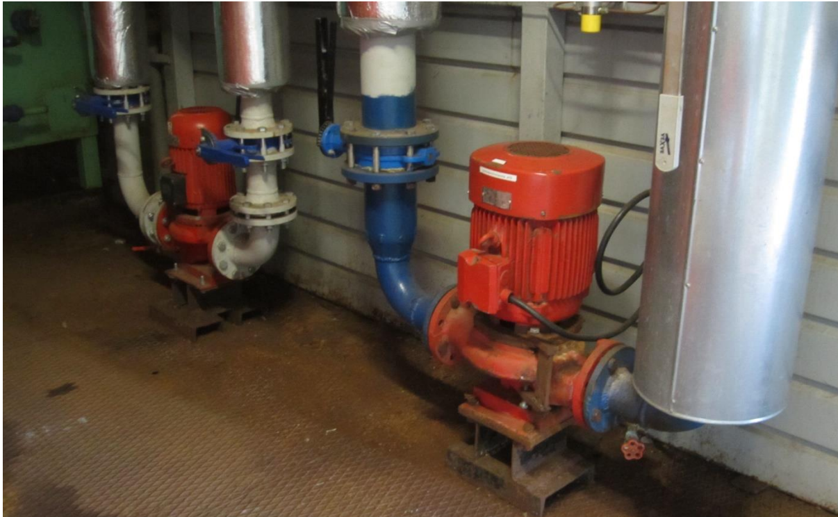
Joonis 2.4 Katlamaja võrgupumbad
