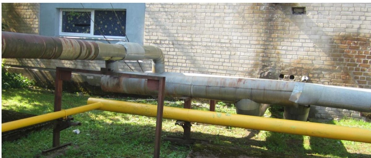
Joonis 2.5. Maapealne kaugküttetorustik katlamaja piirkonnas Jõe 2b
