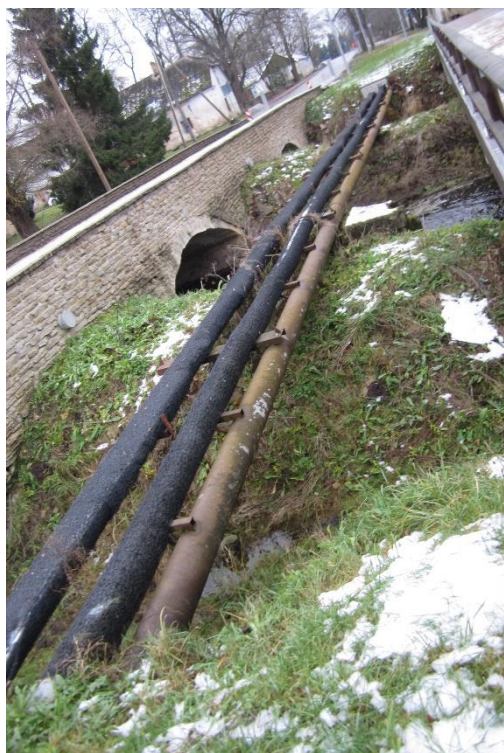
Joonis 2.6. Maapealne torustik Seene 2 soojusvarustuseks
